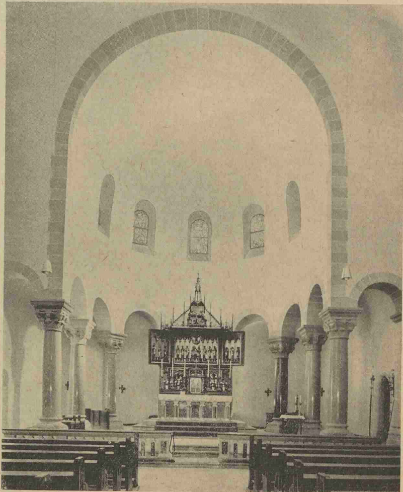
Das Chor der St. Bernarduskirche in seinem neuen, lichten Gewand.
