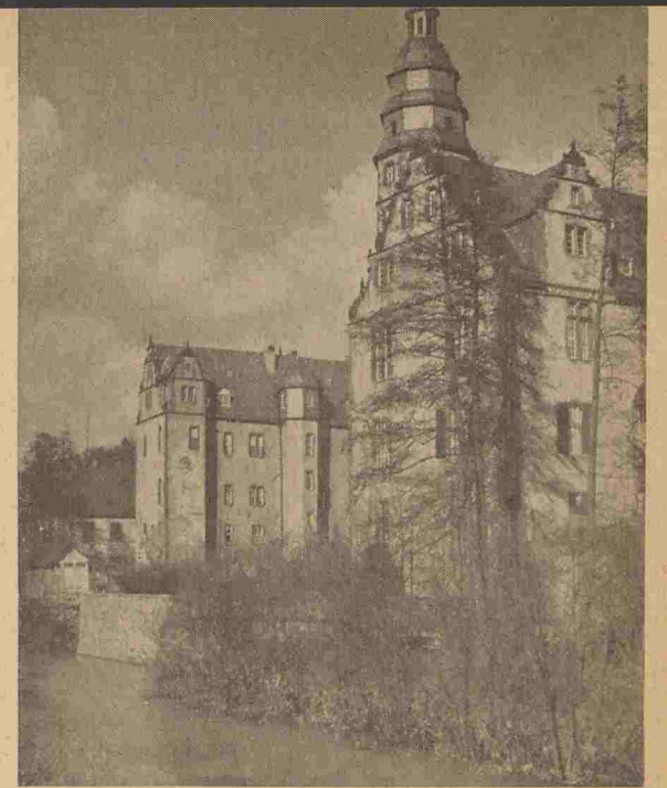
Das Schloß wurde nach 1320 durch den Grafen Emich I. von Nassau-Hadamar als Burg erbaut, vermutlich an der Stelle eines um 1190 erbauten Hofes des Klosters Eberbach. Nachdem die Burg 1540 bei einem Brand zerstört worden war, begann Graf Johann Ludwig den Wiederaufbau, der im wesentlichen 1694 vollendet wurde. Die Gesamtanlage war ursprünglich von Wassergräben umgeben, die Anfang des 19. Jahrhunderts zugeschüttet wurden. Heute befindet sich im Schloß das Hadamarer Gymnasium.
